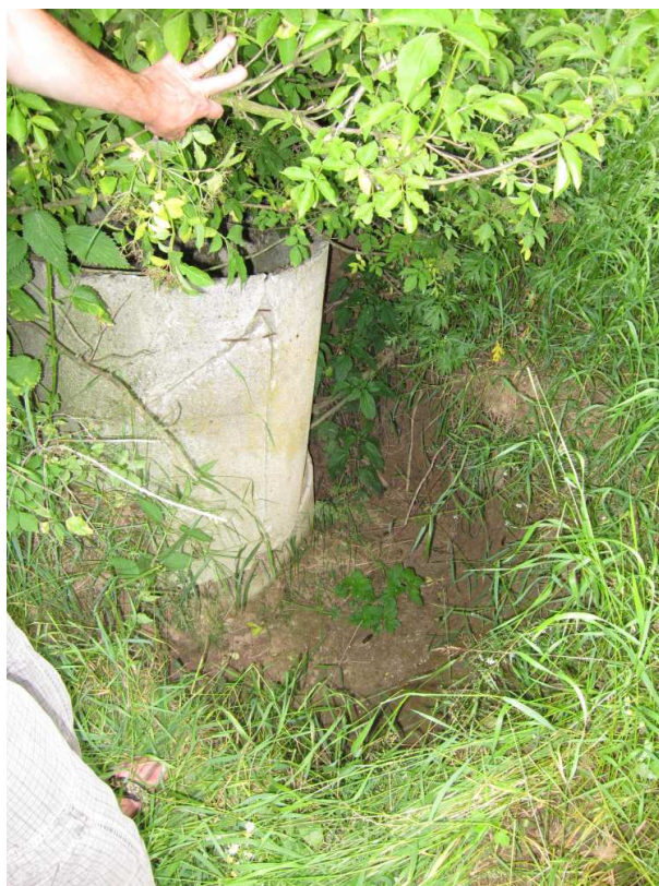
Obr. IP3 – šachta drenážního systému poškozená vlivem proudící vody
